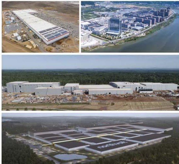
图 12. 世界各地的锂离子电池工厂，从左上角沿顺时针方向：特斯拉在内华达州的 35 GWh 工厂；宁德时代在中国宁德的总部和 45 GWh 工厂；SK 在乔治亚州的 10 GWh 工厂；Northvolt 在建的 16 GWh 设施的渲染图。
